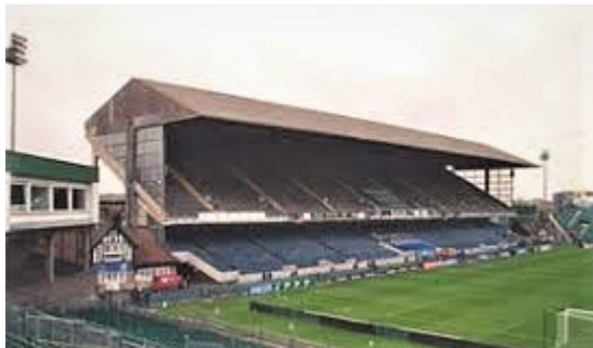
Avant la rénovation...
